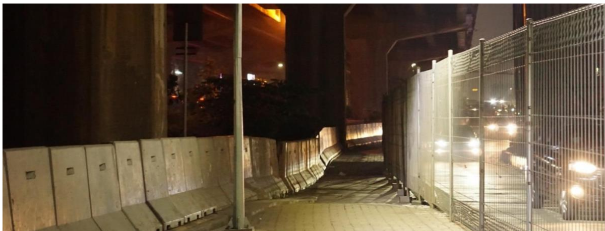
Gambar 3. Jalan masuk dan keluar gerbang A dengan perlengkapan penerangan minimal.
